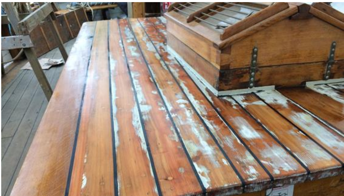
Nach dem Abschleifen der Fugenmasse wurde das Holz mehrfach geölt. Nun fehlt nur noch der Endanstrich, der bei gutem Wetter im Winter gemacht werden soll.
