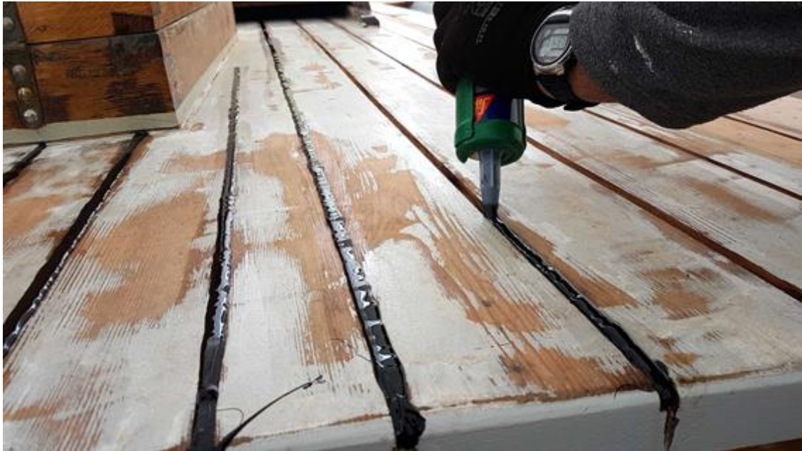
Verfüllen der kalfaterten Fugen.
